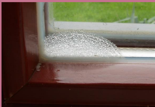
Obr. 6.2 – Závada způsobená vodou
